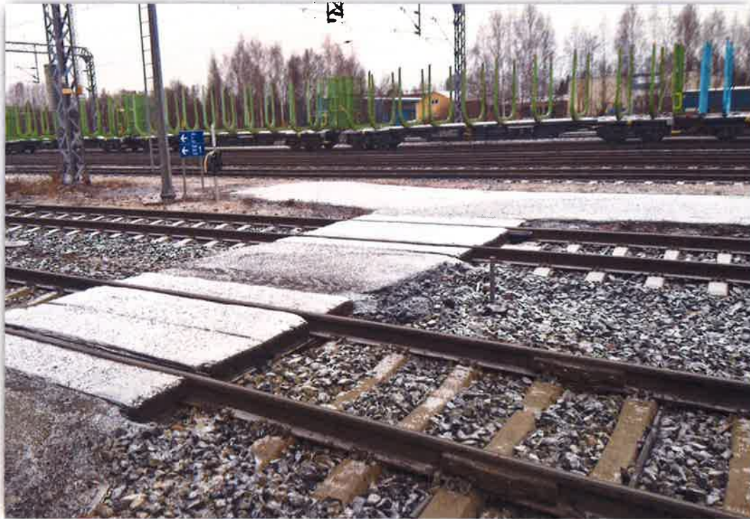
Kuva 1: Kemin aseman pohjoispuolen ykkös- ja kakkosraiteen ylitys
